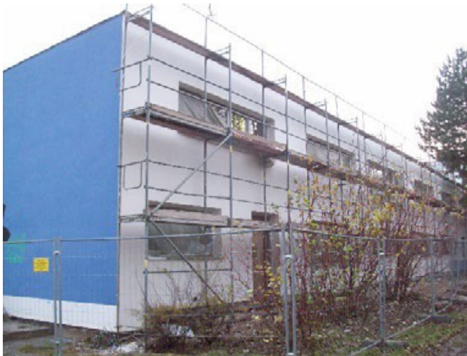
Während des Umbaus
